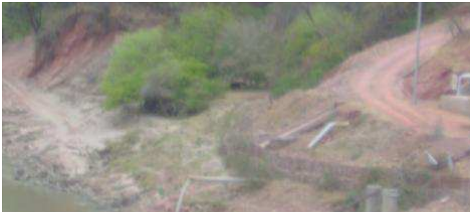
Figura 2: Tomado el 10 de septiembre de 2009 a horas 16:00. Se observa el desagüe de las aguas residuales del campo Sábalo al río Pilcomayo, del mismo que se tiene información que en el día vierte aguas tratadas, sin embargo en horas altas de la noche o madrugada, se vierte aguas no tratadas y que despiden un fuerte olor. Hasta la fecha no se tiene datos de laboratorio que pruebe el grado de contaminación de dichas aguas. Foto: LIDEMA/CER-DET/Fundación MADALBO.
